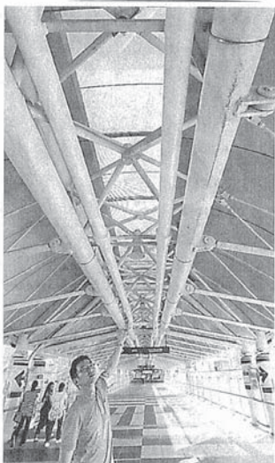
府咲洲庁舎とアジア太平洋トレードセンターの空調設備をつないで熱を伝える「サーマルグリッドシステム」の導水管（内側の2本） 大阪市住之江区で、幾島健太郎撮影
